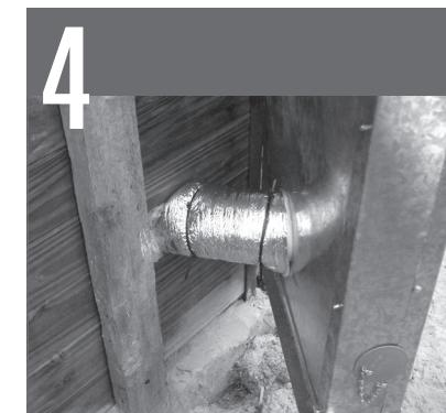
Colocar el calentador ya armado insertando las salientes de los cuatro conductos en las perforaciones ya realizadas en la chapa de fondo.
