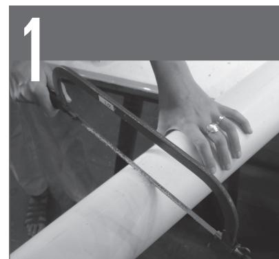
1 Cortar cuatro (4) caños de PVC liviano diámetro de 110 mm de un largo que sea igual al espesor del muro donde se coloque el calentador más 10 cm.
