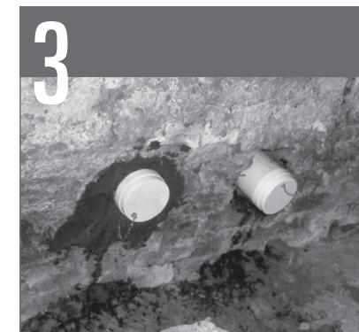
Colocar los caños, en forma horizontal, dejando 5 cm para cada lado de la pared (*interior y exterior*) y sujetarlo firmemente.
