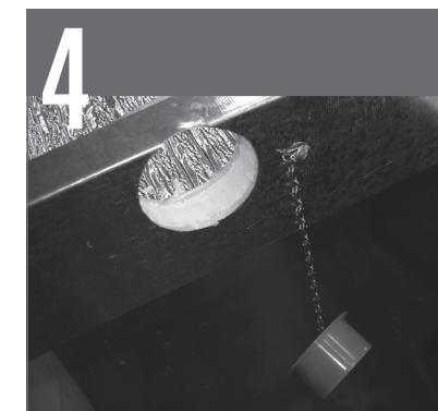
4 En el período cálido, se deberán abrir estas tapas para que se produzca la descarga del aire caliente hacia el exterior, o accionar el sistema para que actúe como extractor natural.
