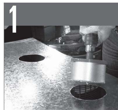
Realizar sobre la chapa lisa de 1 x 2 m, cuatro perforaciones de un diámetro de 11 cm. Se realizarán a 15 cm del borde de 1 m y a 30 cm del borde de 2 m (ver esquema abajo).
