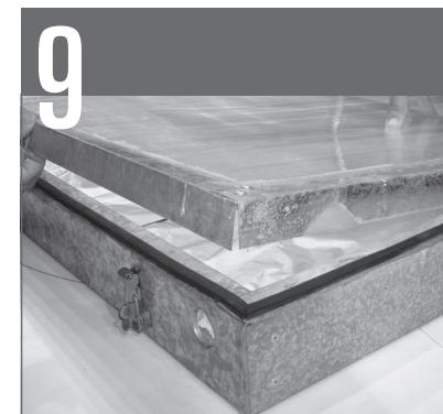
Si se utiliza policarbonato, hacer calzar la plancha en los laterales, previa colocación del pegamento siliconado, sellar y dejar secar.
